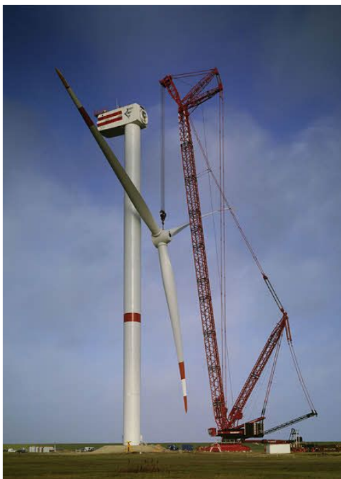
Kuva 3. Tuulivoimalan pystytys tela-alustaisella nosturilla (Liebherr).
