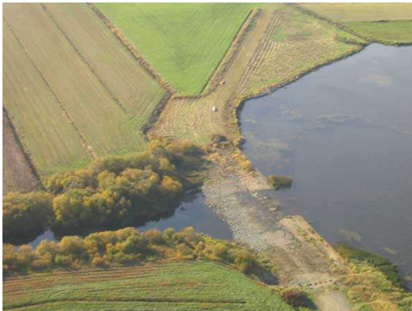
Kuva Piipsjärven ja Piipsanjoen välisestä padosta.
