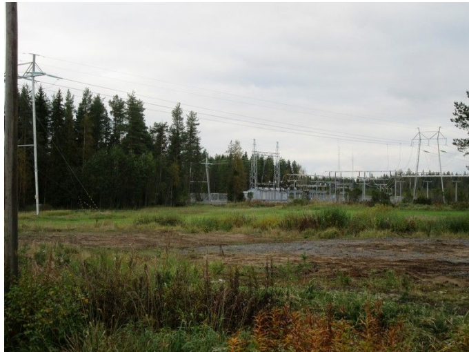
Kuva 20 VL. Pyhäkosken sähköasema kuvattu luoteeseen.
