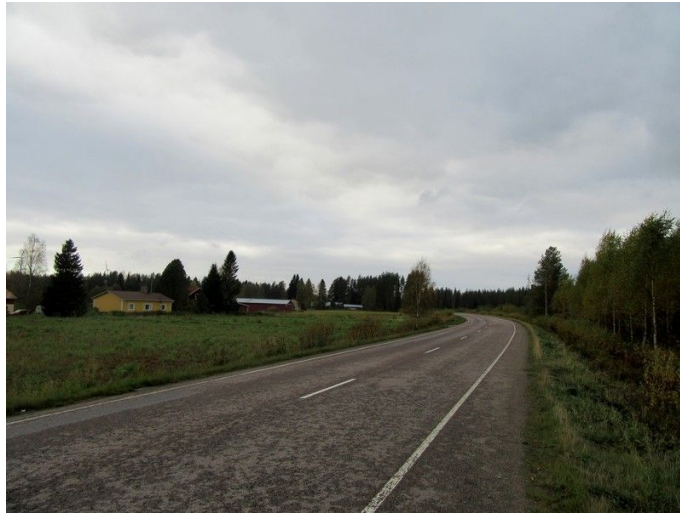
Kuva 19 VL. Linjaus SVG 1 / 2 Hiitoperän kohdalla, tie 7980 kuvattu länteen.
