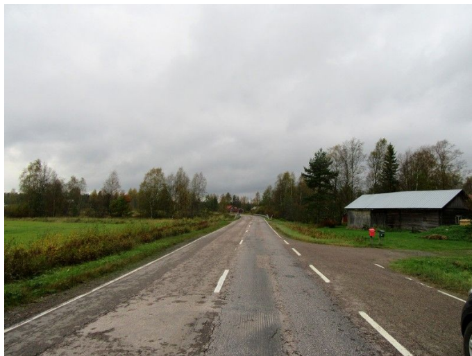
Kuva 18 VL. Linjaus 1 / 2 Ylikylän kohdalla, tie 7980.
