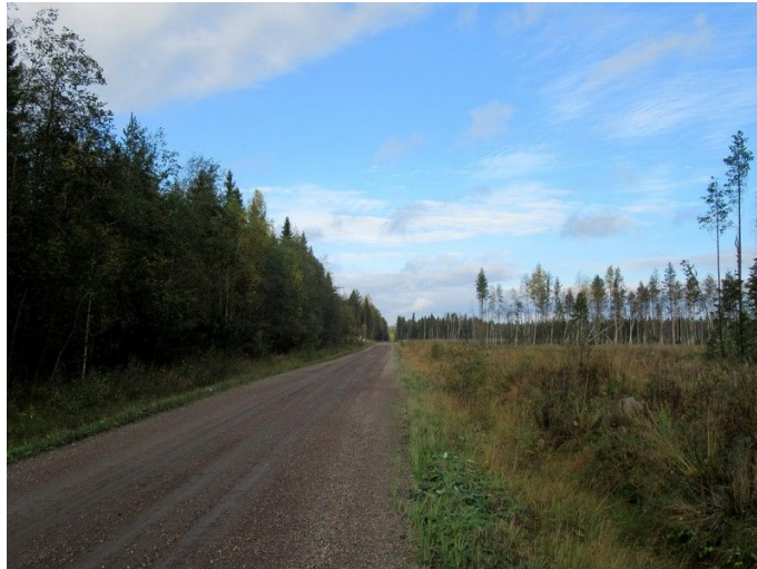
Kuva 26 VL. Linjaus SVG 3 / 4 Keskikylän eteläpuolella, tie 18241, tasainen kivinen kangas, kuvattu pohjoiseen.
