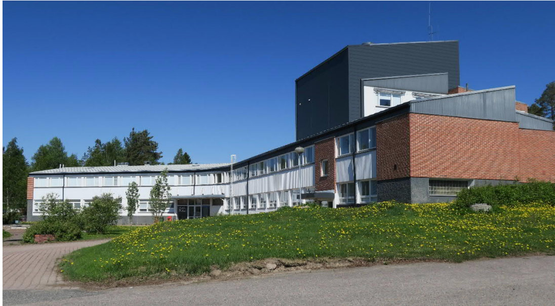
Kuva 33. Revon Sähkö Oy:n pääkonttori.
